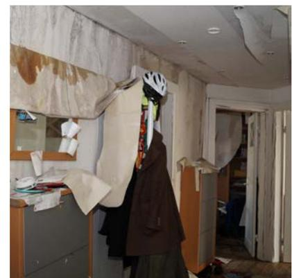
Links: Großbrand in Eimsbüttel: nach Feuer-, Rauch- und Löschwasserschäden bis in den Keller Kernsanierung von 32 Wohnungen erforderlich / Mitte: Verrußtes Treppenhaus nach Dachstuhlbrand / Rechts: Durchfeuchtete Wände, aufgequollene Türzargen
